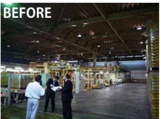
設置前の写真(光っているのが水銀灯)
