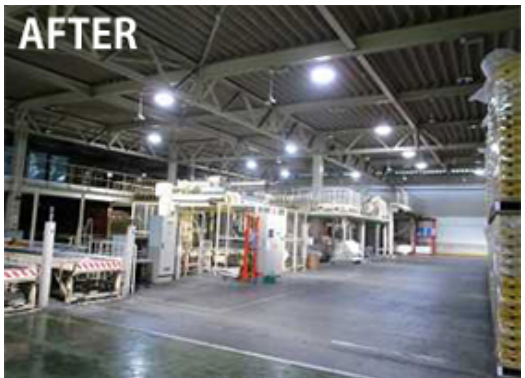
ソーラマスター設置後(明るく輝いているのがソーラマスター)
