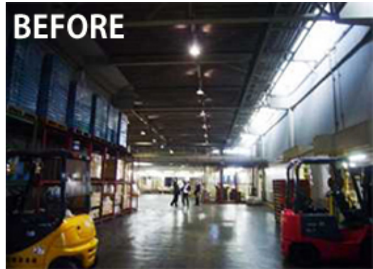
設置前の写真(光っているのが水銀灯)
